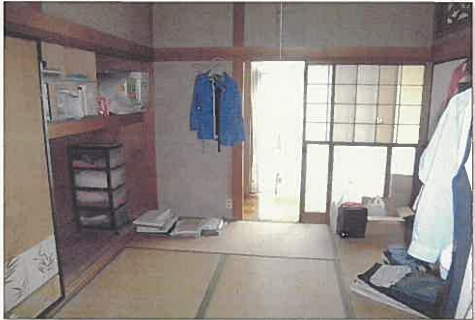
床が大きく沈み込んでいる
