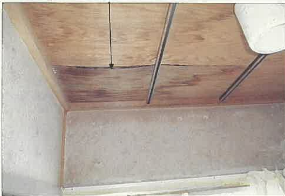
天井の腐食(雨漏りの発生)
