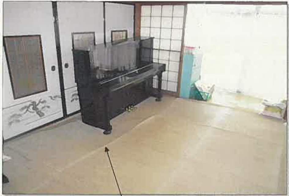
床が大きく沈み込んでいる
