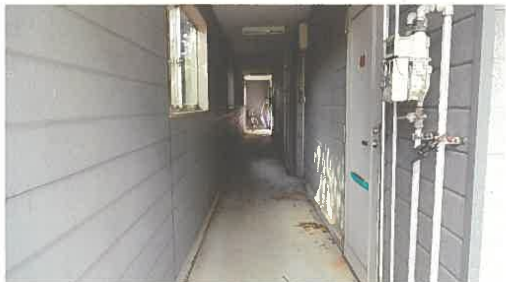
物件 3 建物内部の状況（1 階廊下）
