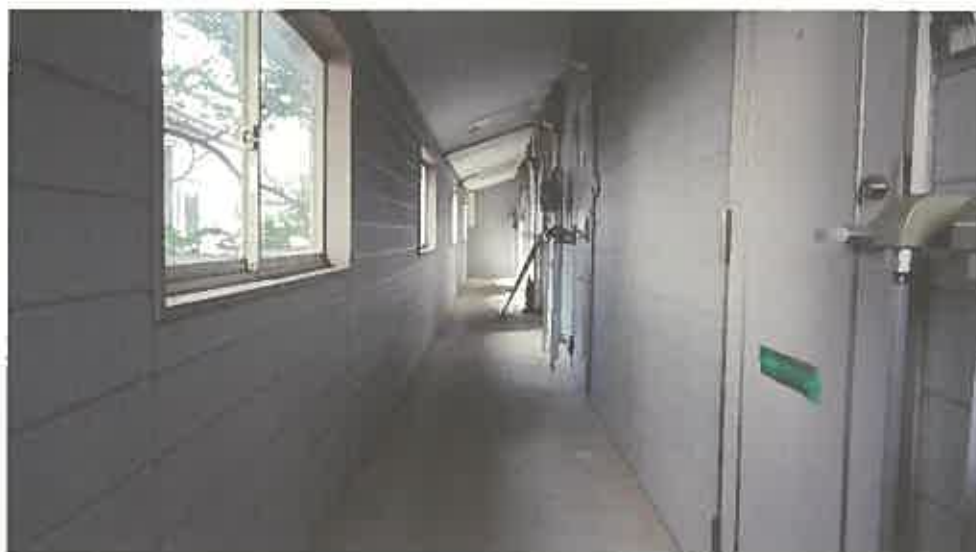
物件 3 建物内部の状況（2 階廊下）
