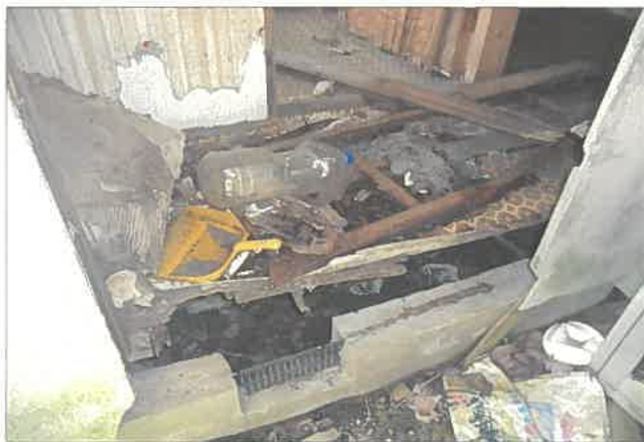
1階部分(床の腐食により立ち入り不能)
