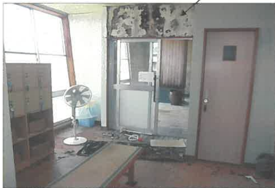
壁が剥がれ落ちている
