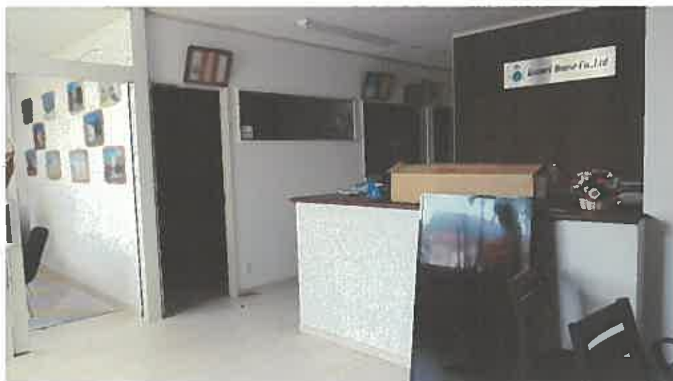
物件 2 建物内部の状況（1 階）
