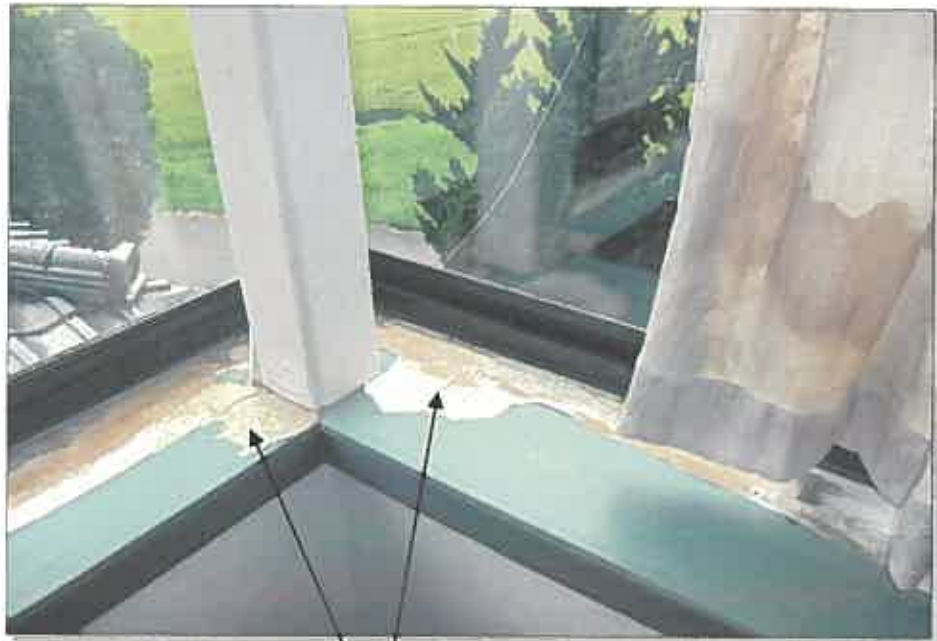
出窓の床板の損傷
