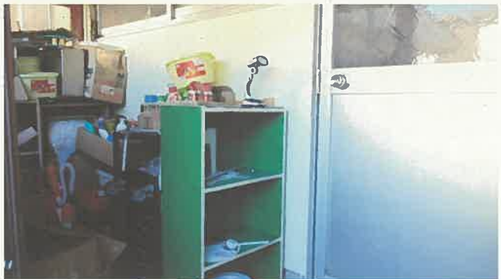
下屋内部の状況
