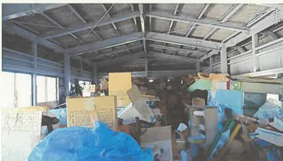
物件5建物内部の状況 (3階)
