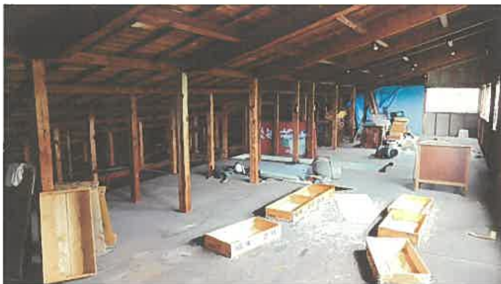
物件 4 建物内部の状況（2 階）
