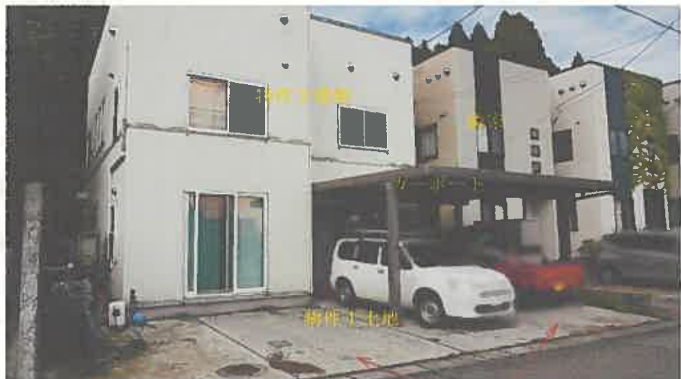
市道敷がコンクリート舗装された部分
