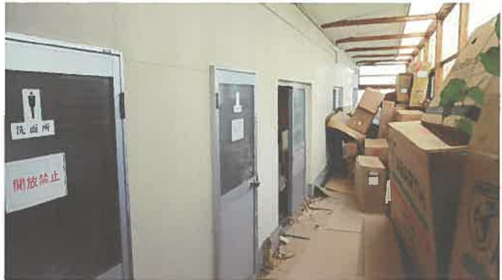
物件 2 未登記附属建物 3 内部の状況
