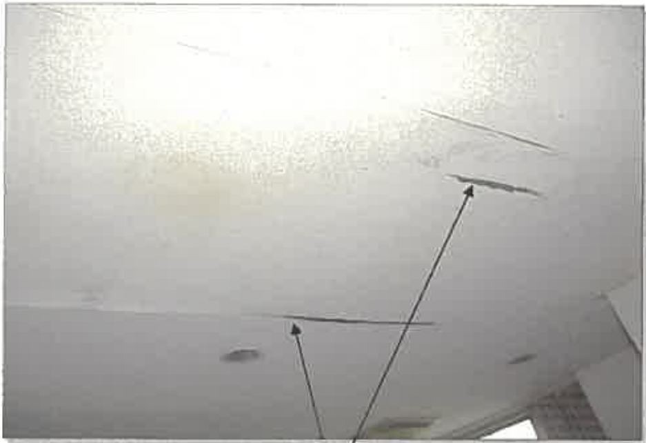
天井クロスの損傷
