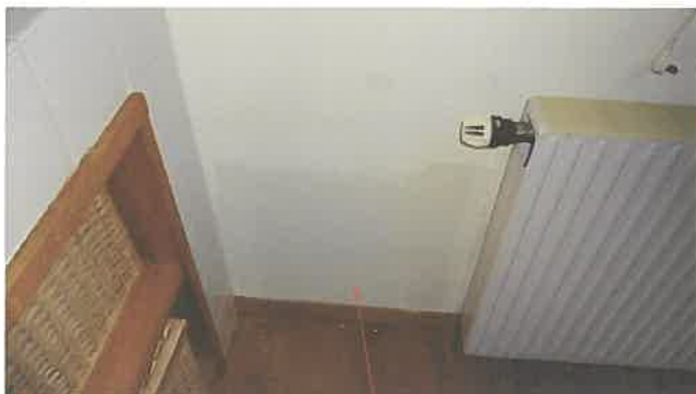
前同 (内壁の補修跡)
