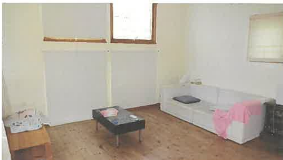
物件 3 建物内部の状況（2 階）
