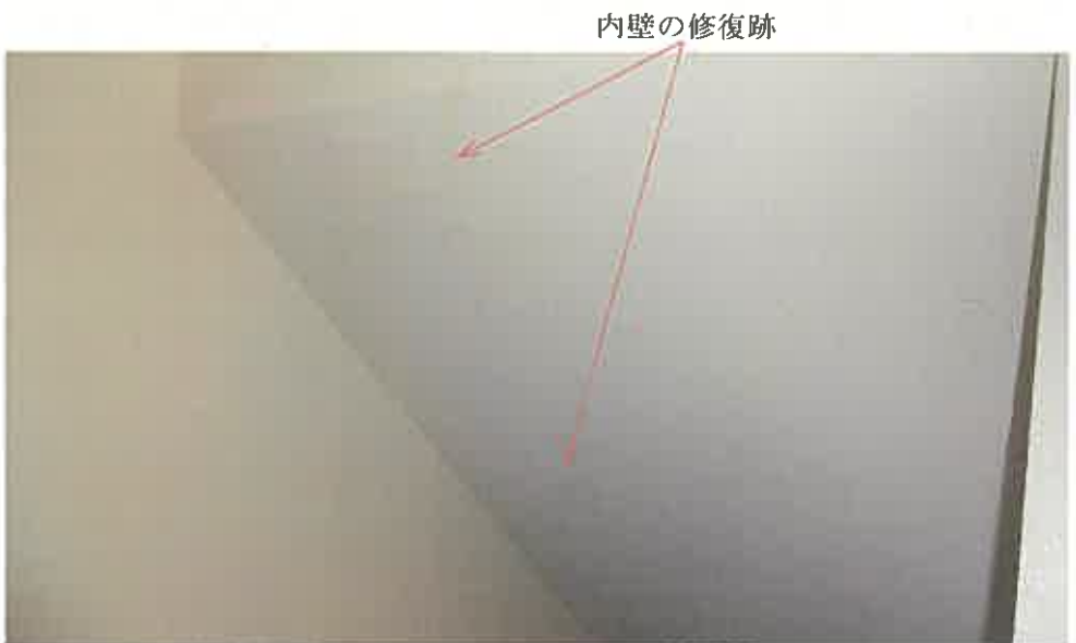
物件 3 建物内部の状況（2 階に上がる階段上）
