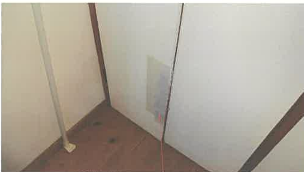
前同（建具の損傷部分の補修跡）
