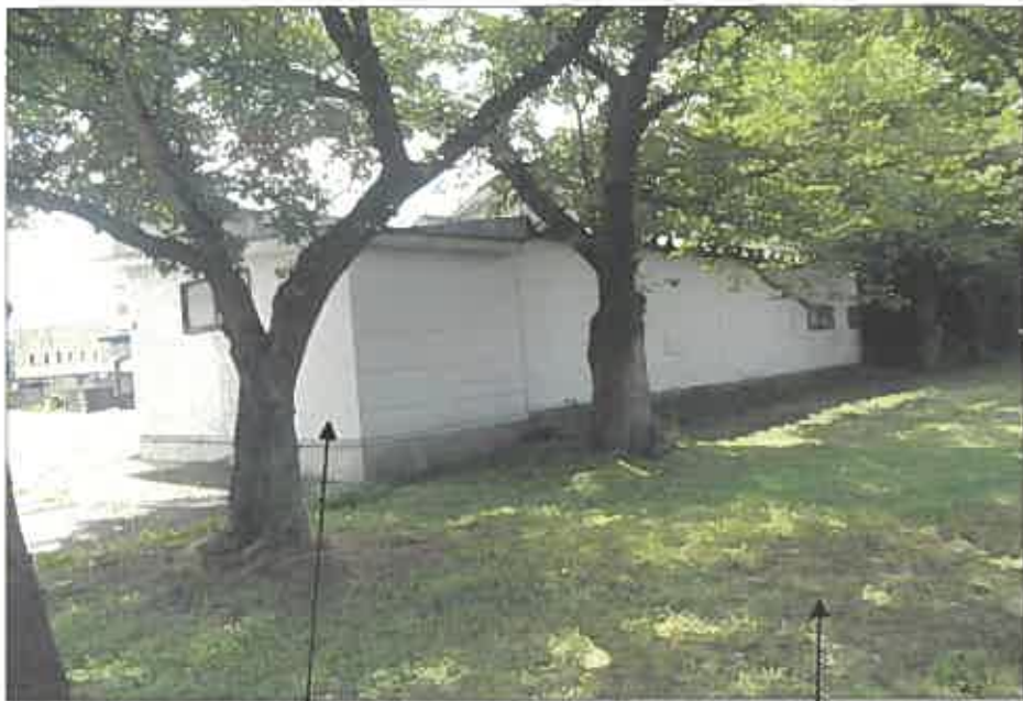
物件5の附属建物
