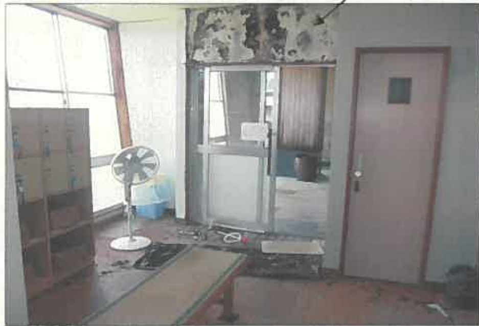
壁が剥がれ落ちている
