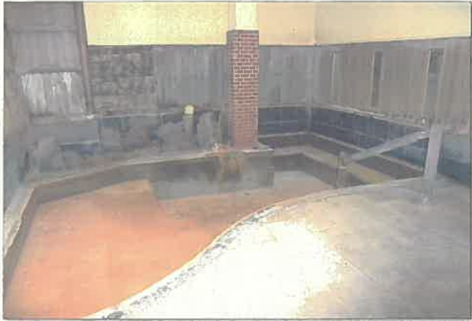
壁が剥がれ落ちている
