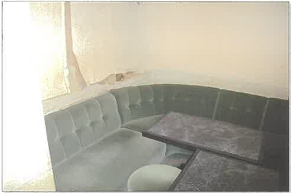
雨漏りによる天井の損傷
