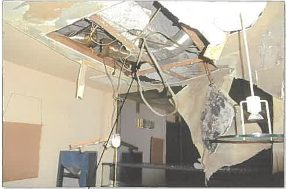
雨漏りによる天井の損傷
