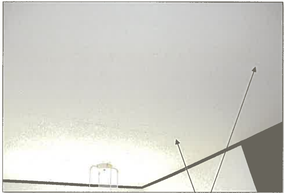
天井クロスの亀裂
