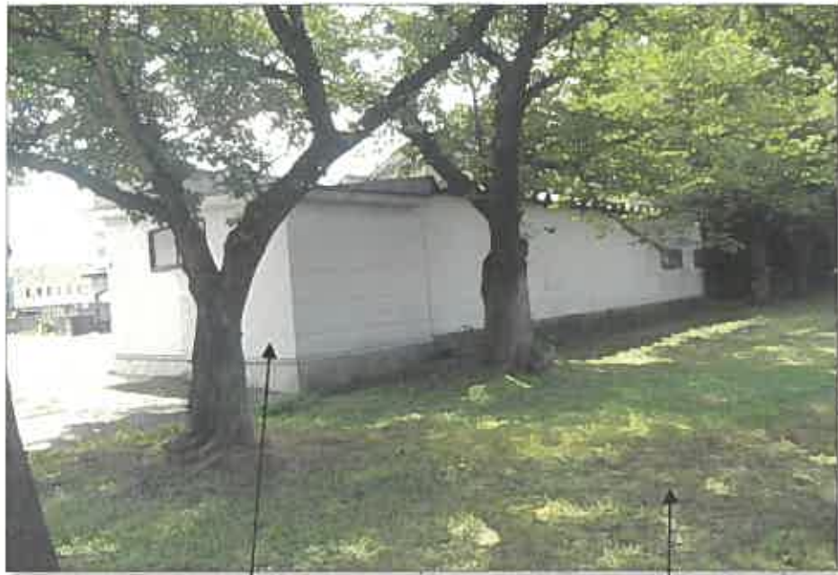
物件5の附属建物
