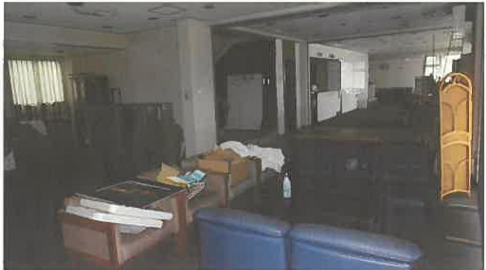
物件 1 1 建物内部の状況 (1 階)
