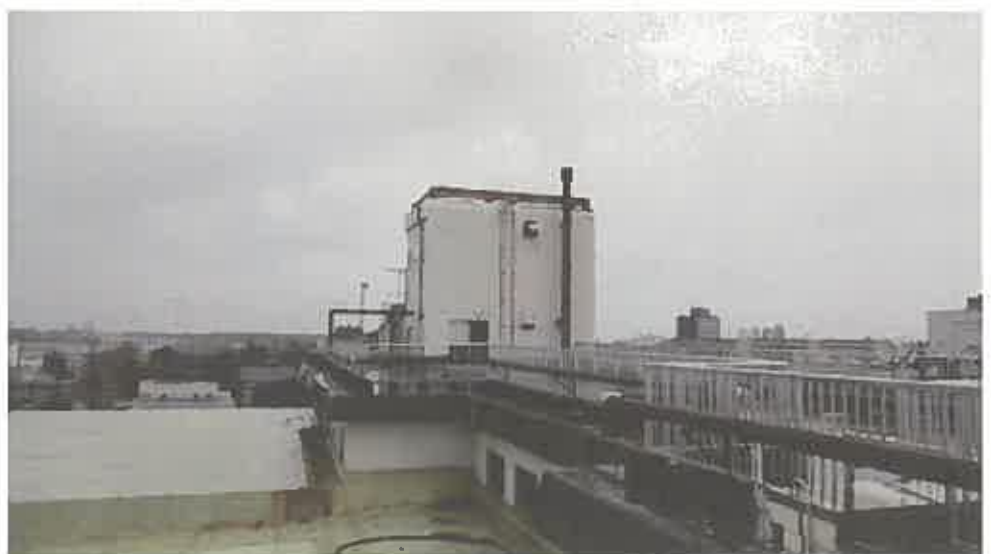
物件 1 1 建物屋上の状況
