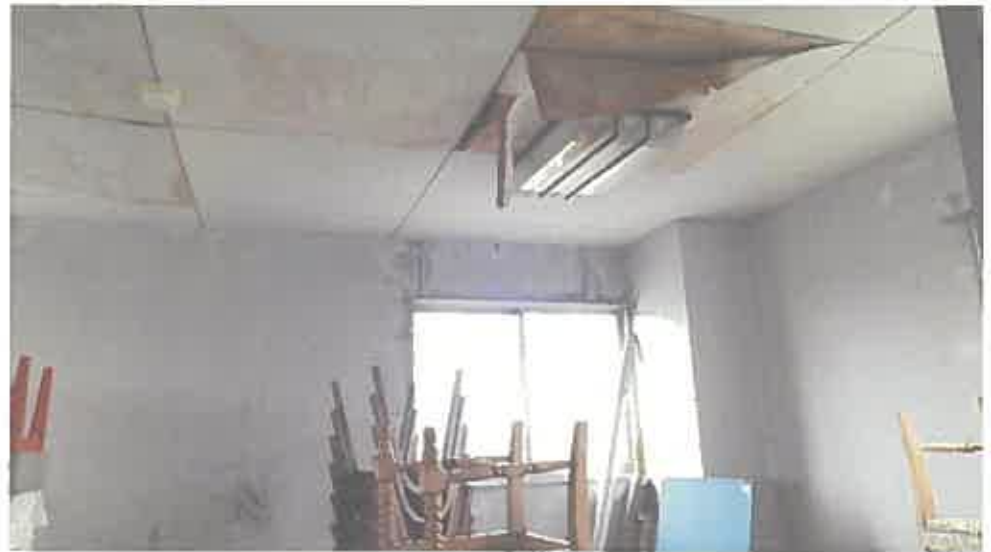
物件 1 1 建物内部の状況 (5 階)
