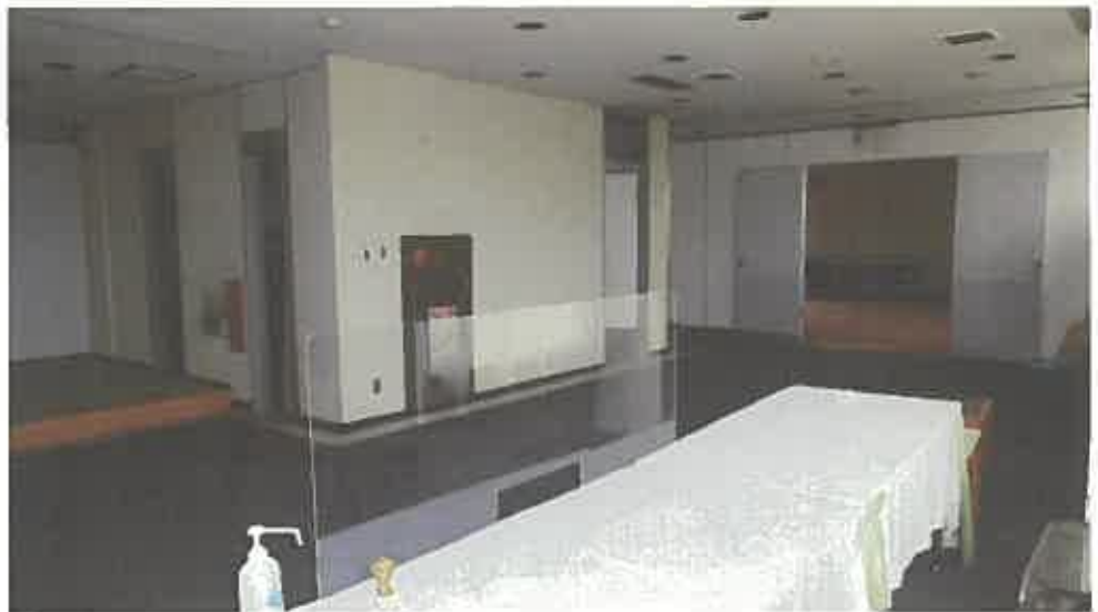
物件 1 1 建物内部の状況 (2 階)
