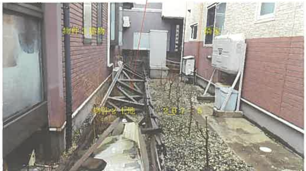
木製フェンスが倒壊している
