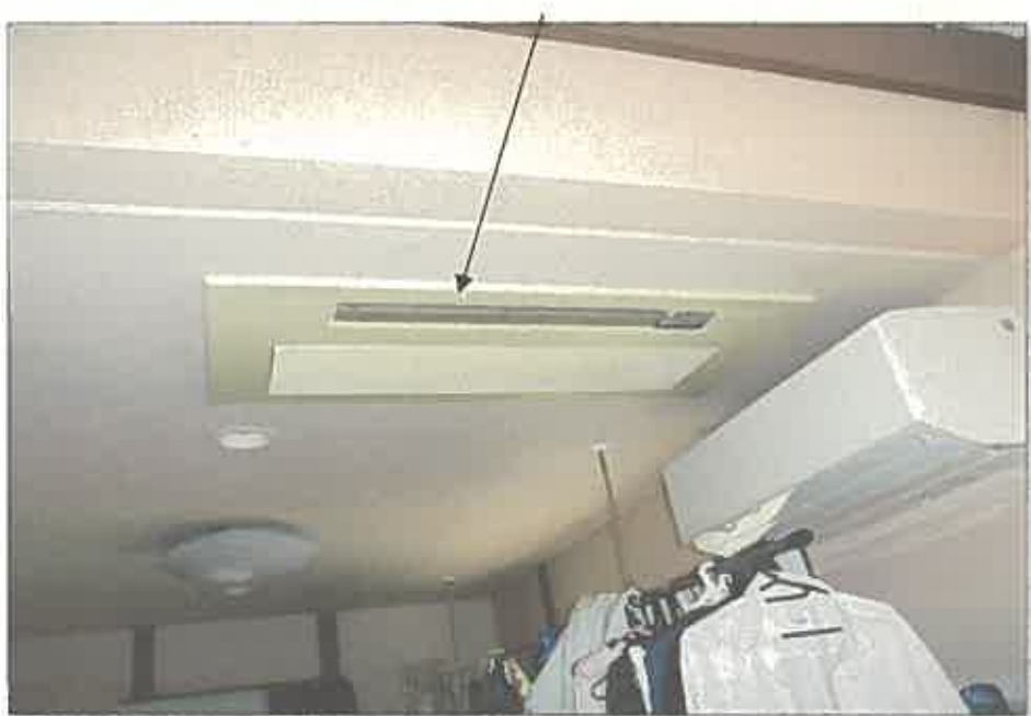
天井埋込型エアコン(故障していて使用できない。)
