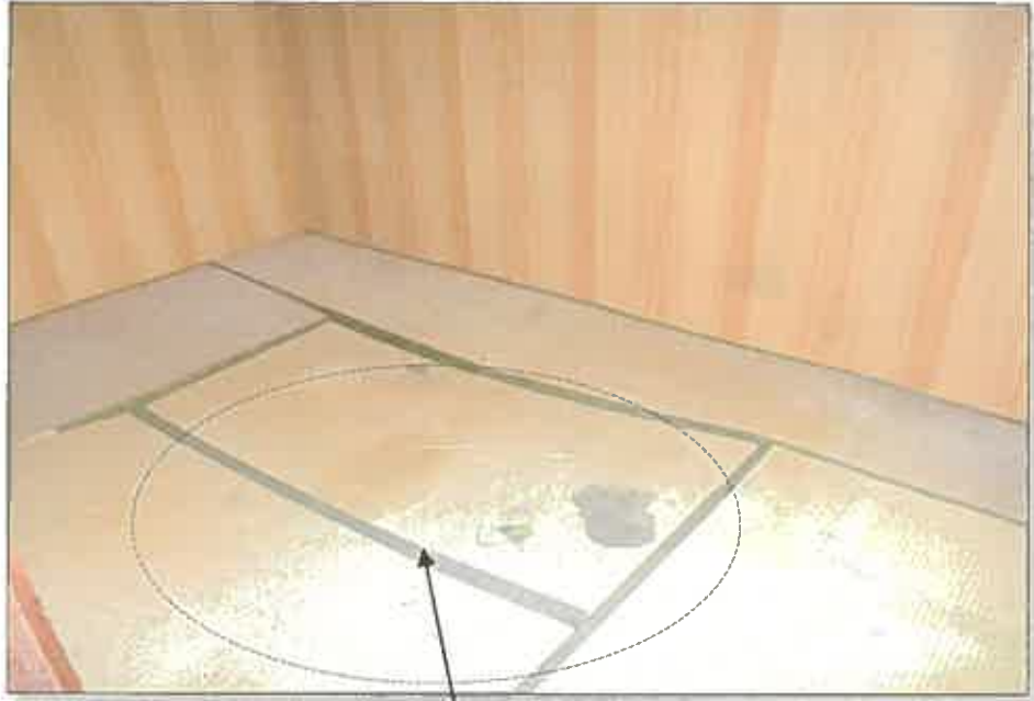
床の中央部分が沈み込んでいる。
