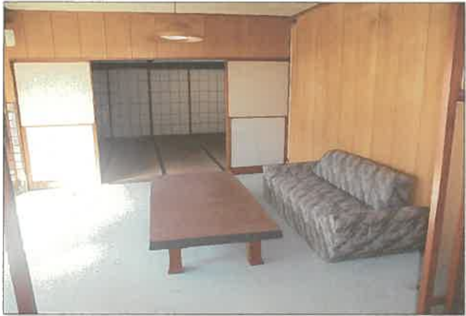
床の中央部分が沈み込んでいる。
