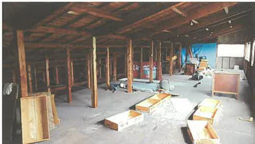
物件 4 建物内部の状況 (2階)
