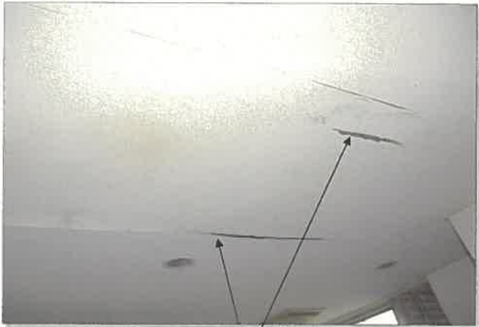
天井クロスの損傷
