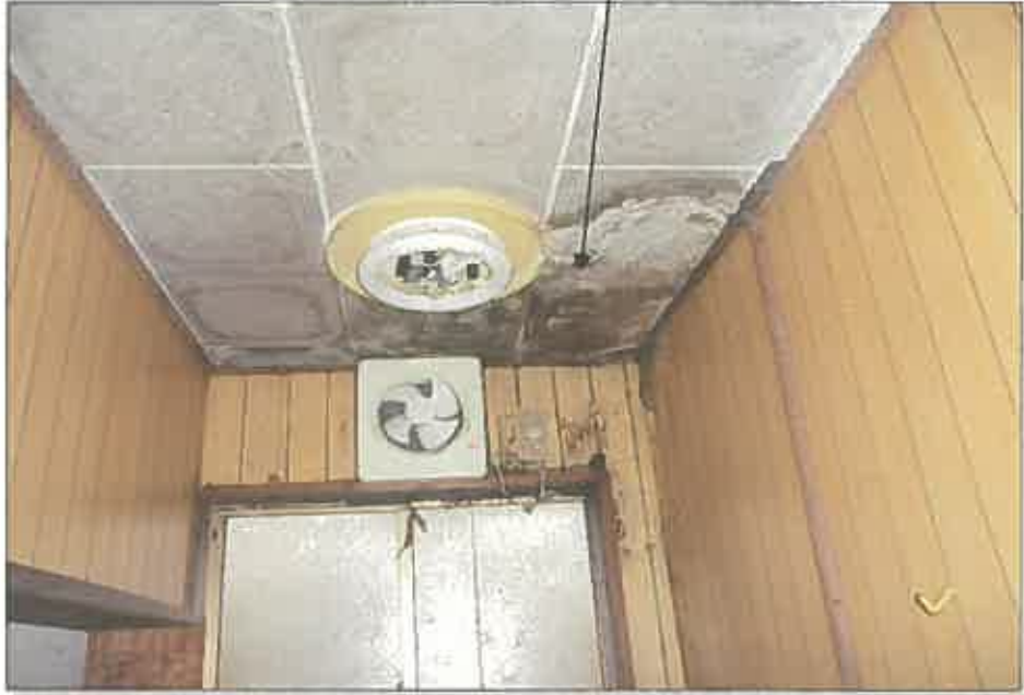
雨漏りによる天井の腐食
