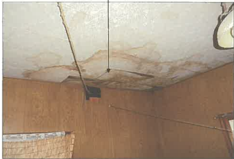
雨漏りによる天井の腐食
