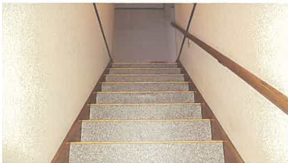
物件3建物内部の状況（2階）
