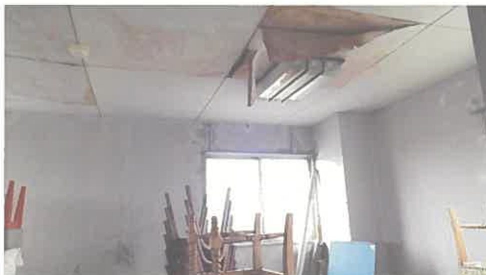
物件 1 1 建物内部の状況（5 階）
