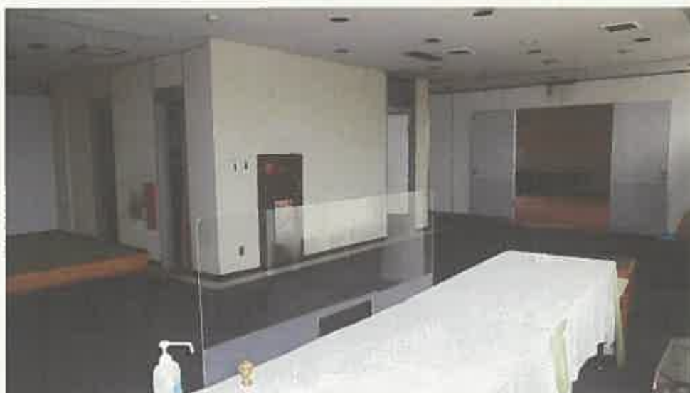
物件 1 1 建物内部の状況（2 階）
