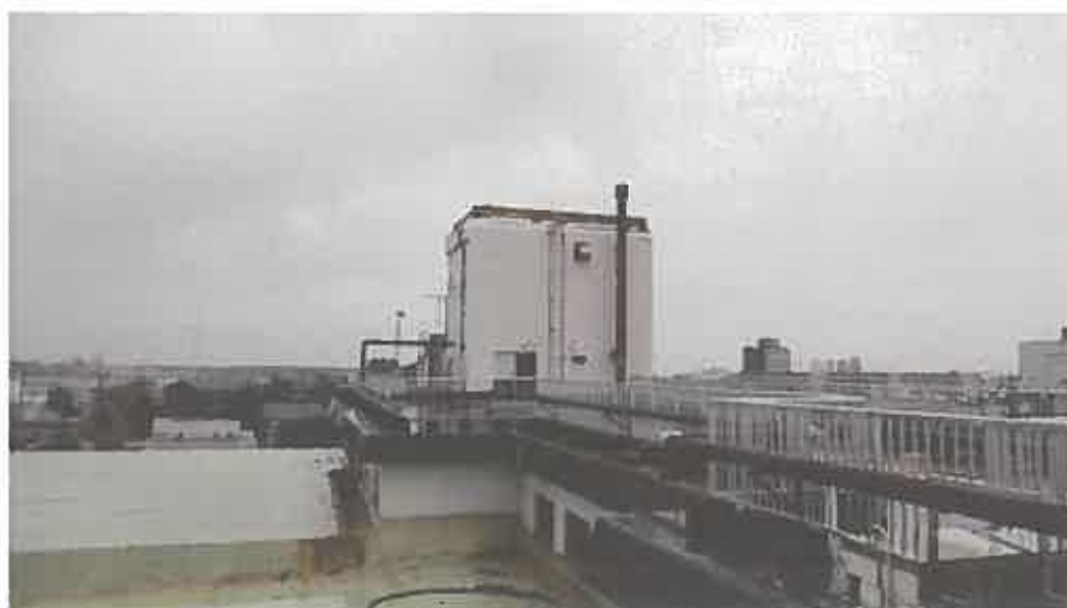
物件 1 1 建物屋上の状況
