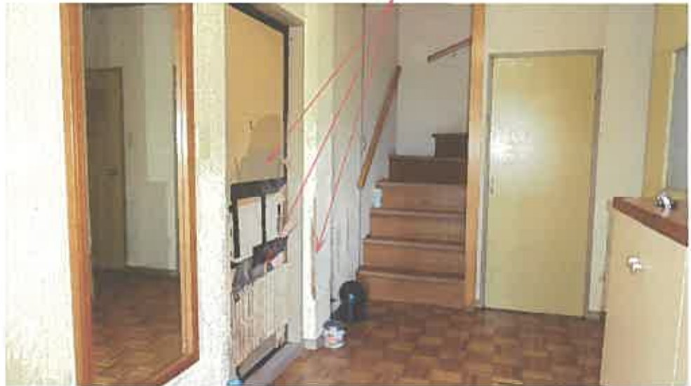
物件 2 主である建物内部の状況（1 階）
