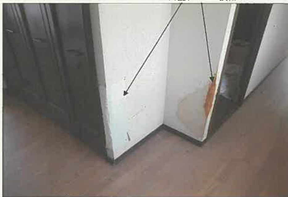
内壁クロスの損傷
