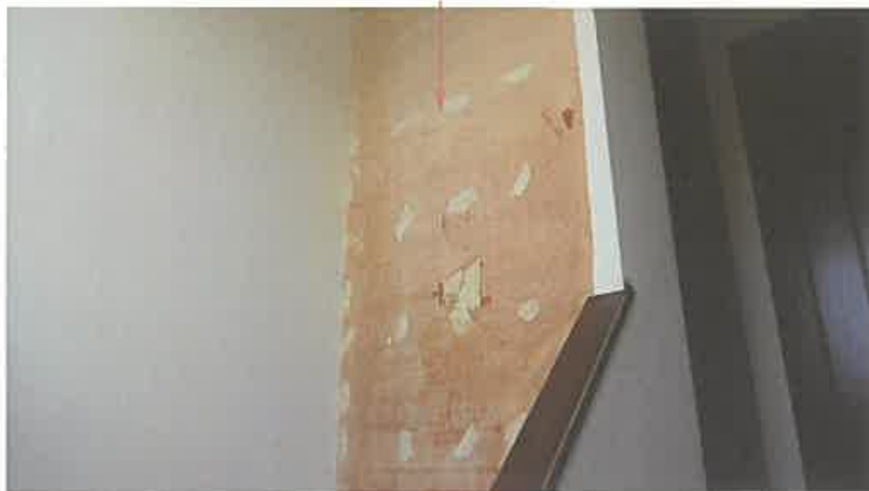
物件 3 建物内部の状況 (2 階)
