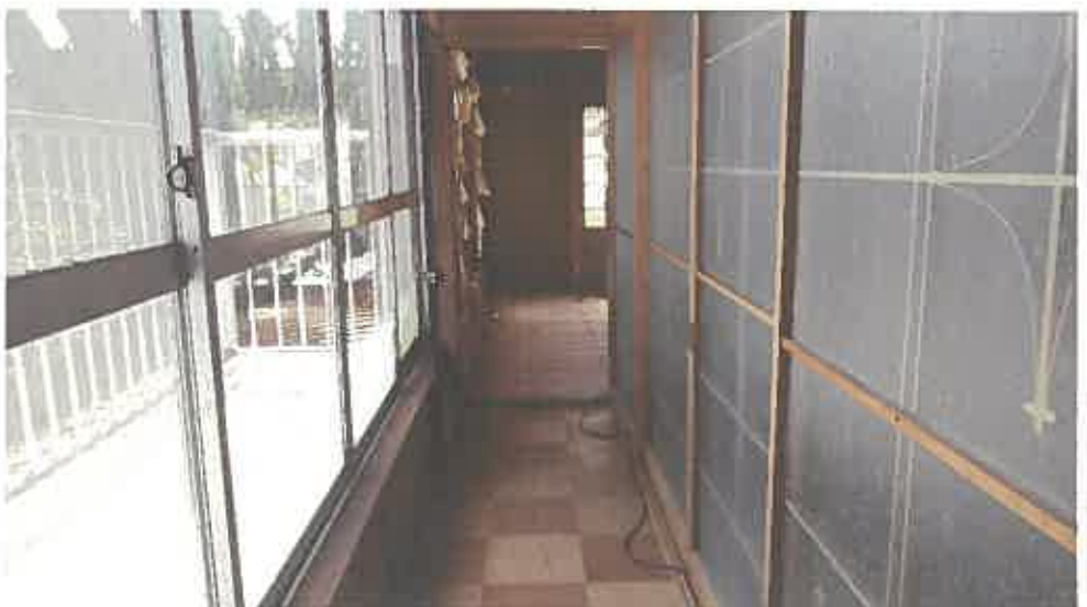
物件 2 主である建物内部の状況（2 階）
