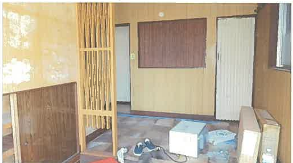
物件2主である建物内部の状況(1階)
