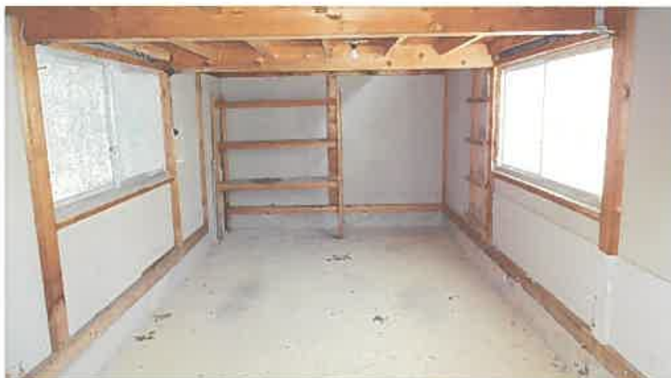
物件 2 未登記附属建物内部の状況（1 階）
