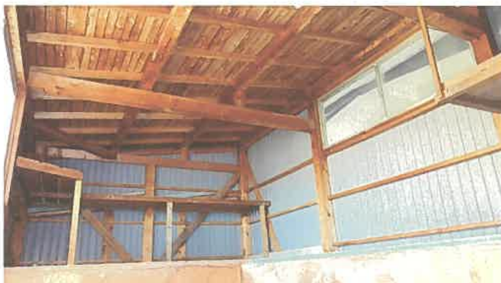
物件 2 未登記附属建物内部の状況（2 階）
