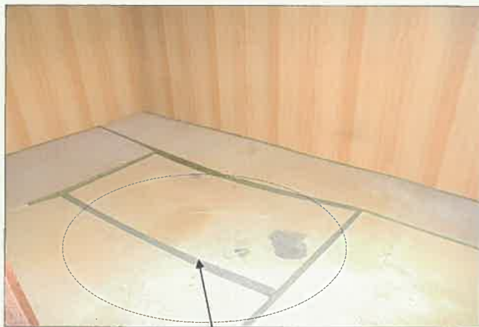
床の中央部分が沈み込んでいる。
