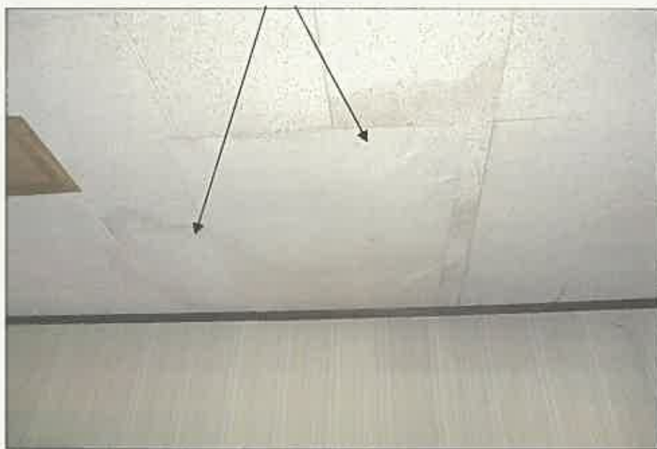
天井の汚れ・損傷
