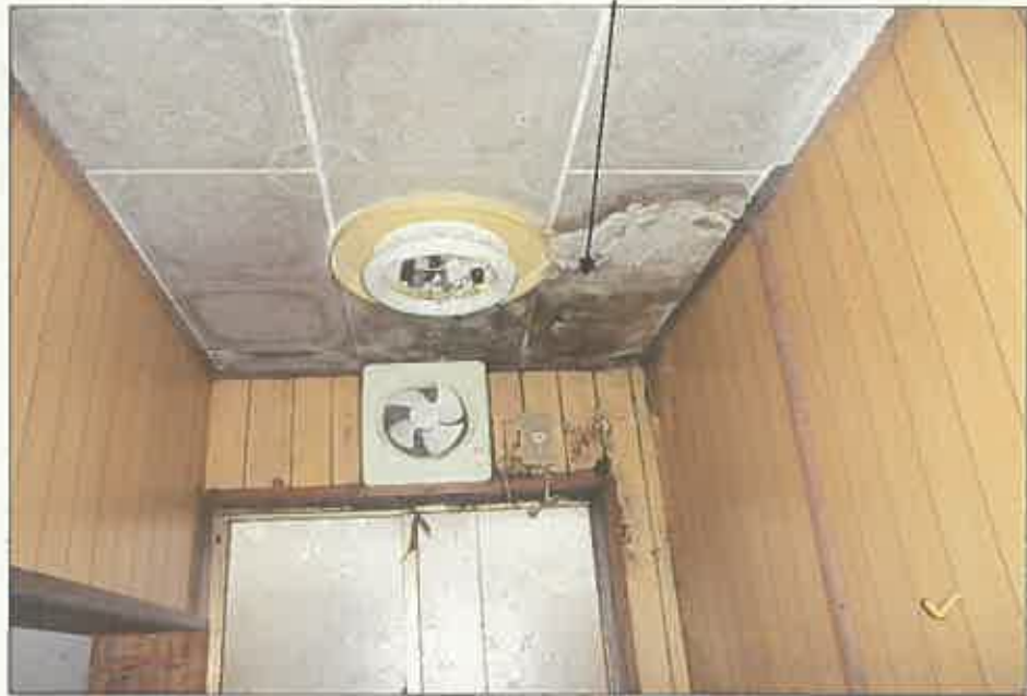
雨漏りによる天井の腐食
