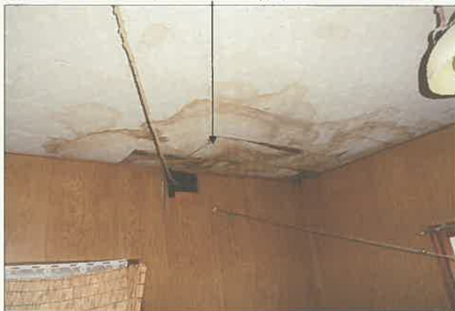
雨漏りによる天井の腐食
