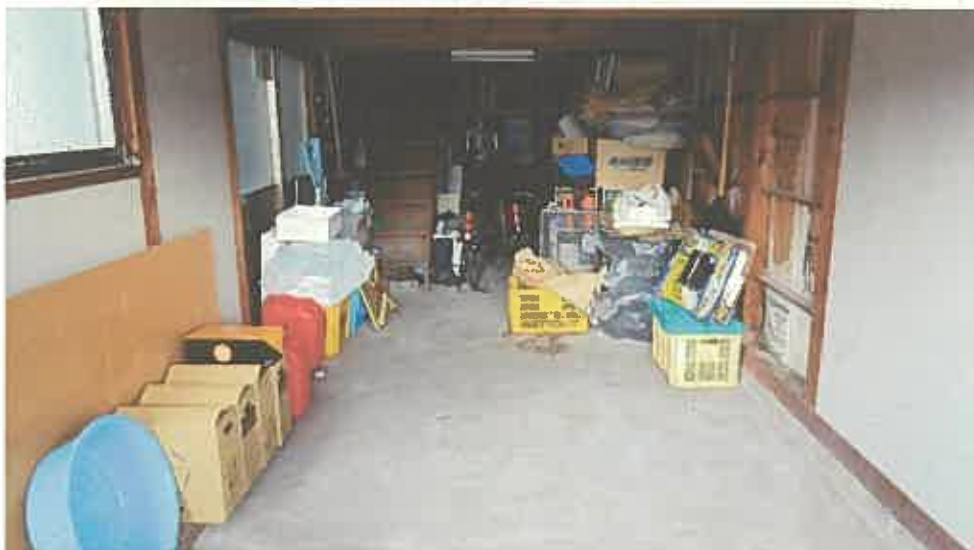
物件2未登記附属建物内部の状況（1階）
