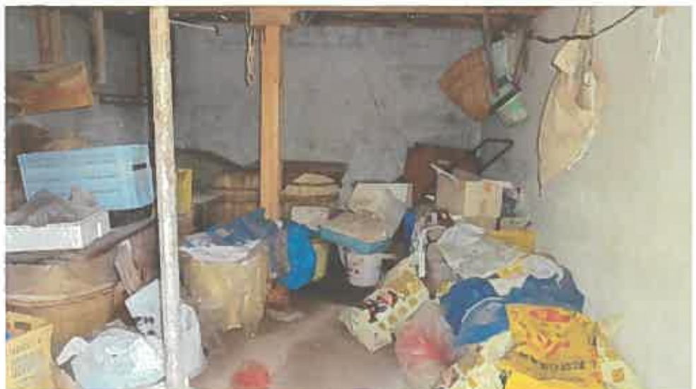
物件 2 未登記附属建物 1 内部の状況
