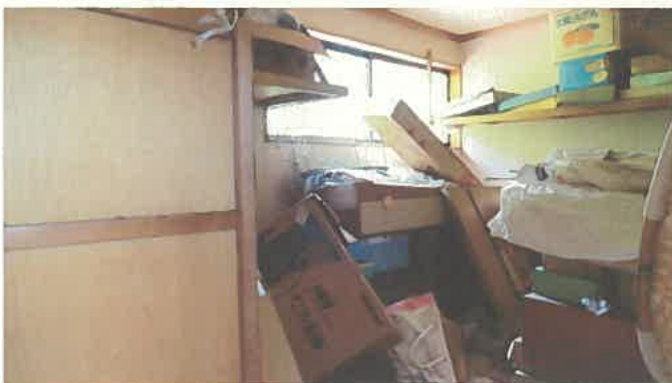
物件 2 主である建物内部の状況（2 階）
