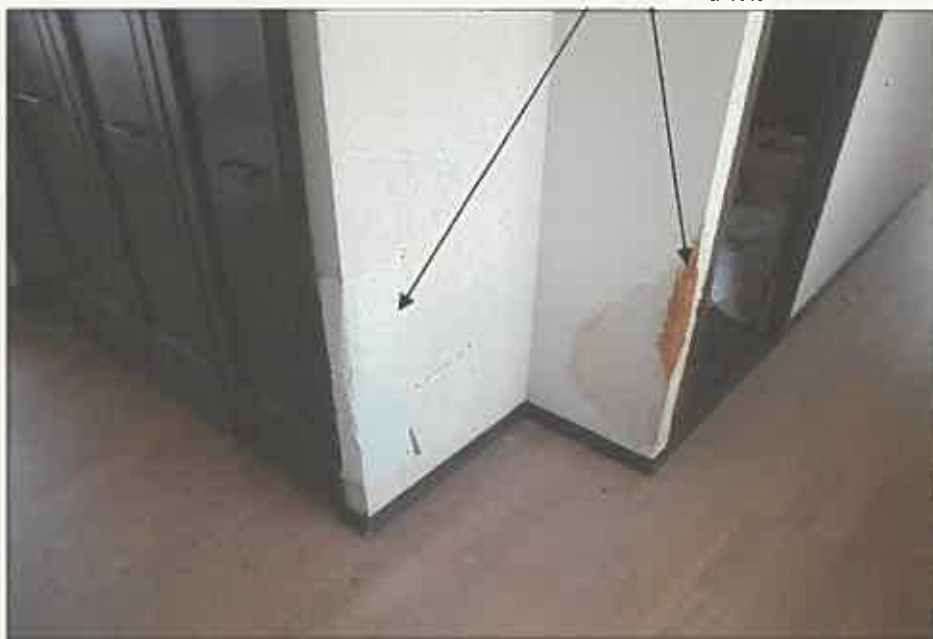
内壁クロスの損傷
