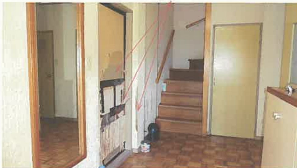
物件 2 主である建物内部の状況（1 階）
