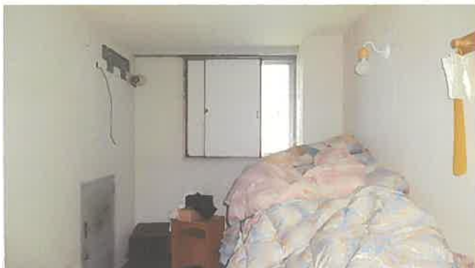
物件 1 1 建物内部の状況（3 階）
