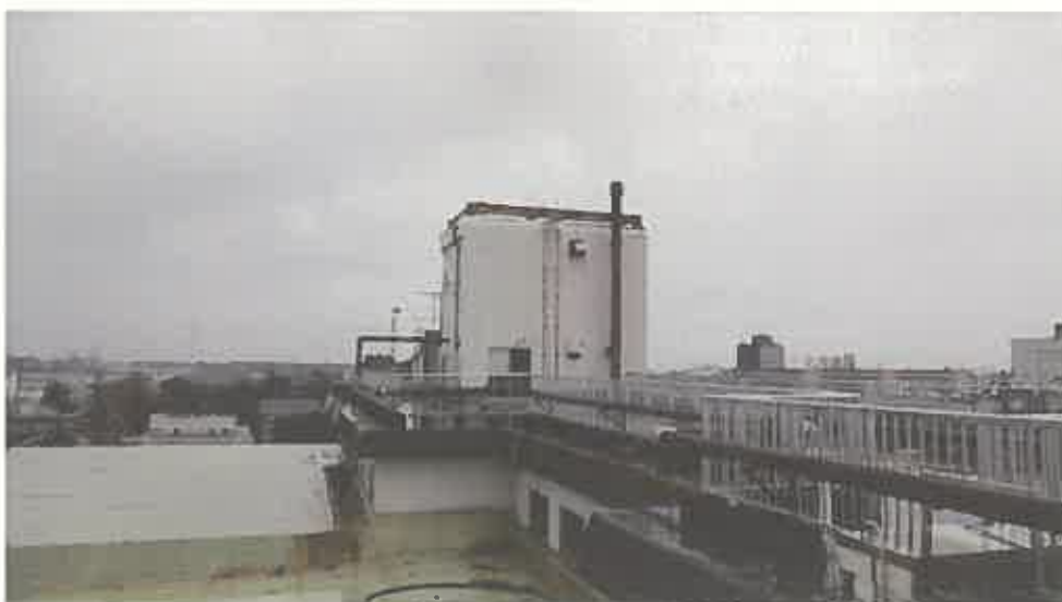
物件 1 1 建物屋上の状況
