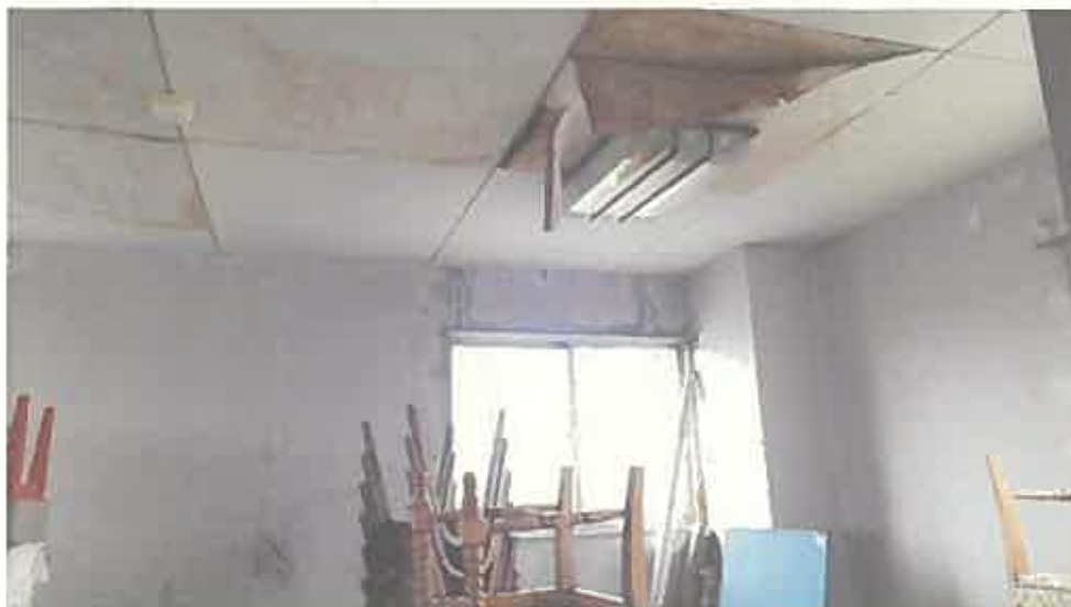
物件 1 1 建物内部の状況（5 階）
