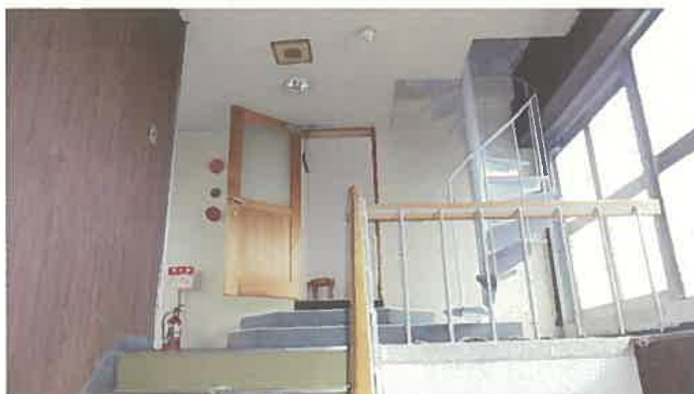
物件 1 1 建物内部の状況（4階）
