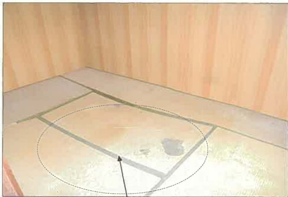
床の中央部分が沈み込んでいる。
