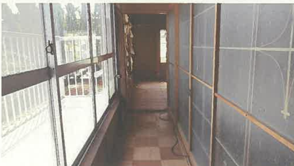
物件 2 主である建物内部の状況（2 階）
