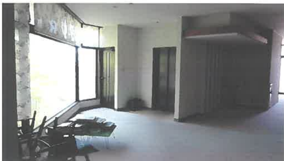
物件 6 建物内部の状況（3 階）
