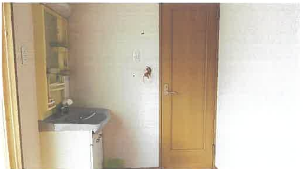
物件 2 建物内部の状況（3 階）
