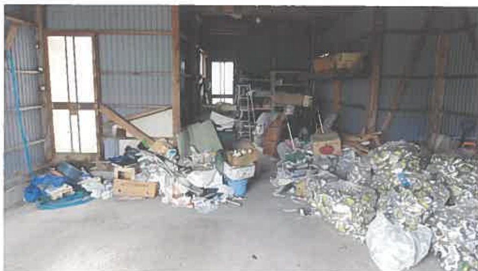
物件3 未登記附属建物内部の状況
