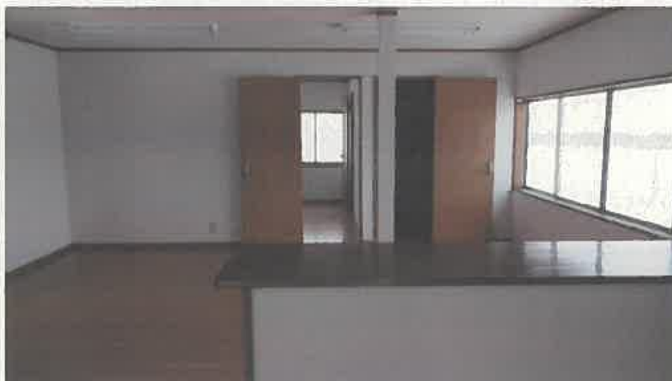
物件 2 建物内部の状況（2 階）
