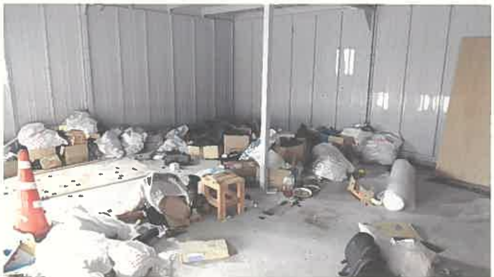
物件 2 未登記附属建物内部の状況
