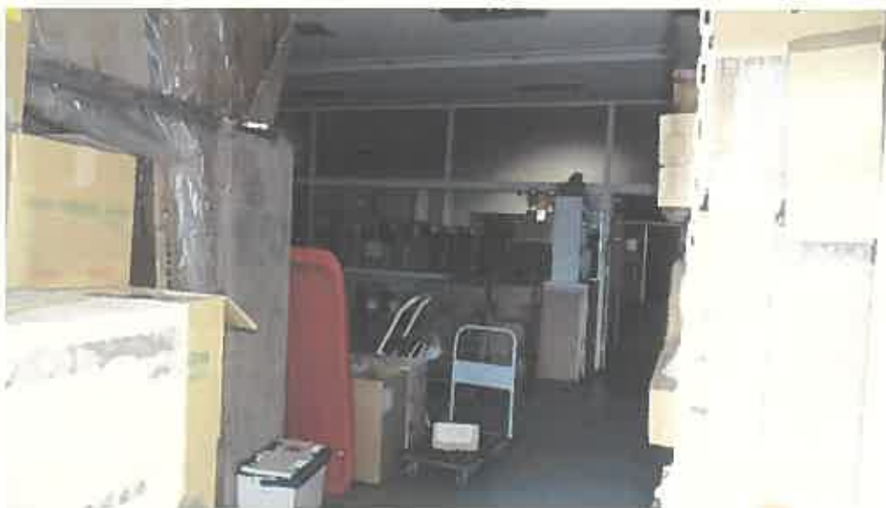
物件2建物内部の状況 (1階)
