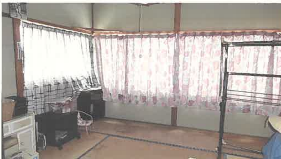
物件5建物内部の状況（2階）
