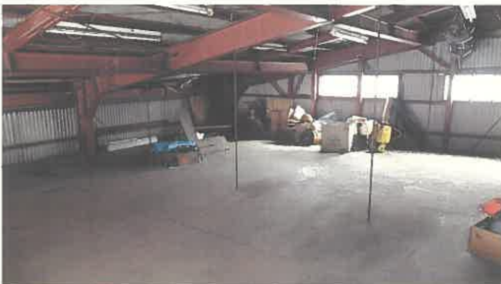
物件 4 主である建物内部の状況（2 階）
