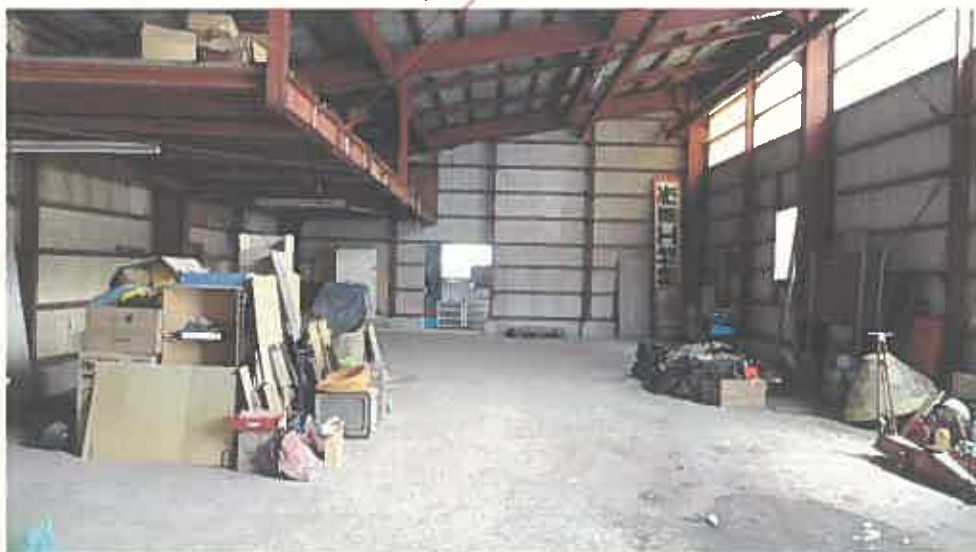
物件4 附属建物符号1 内部の状況
