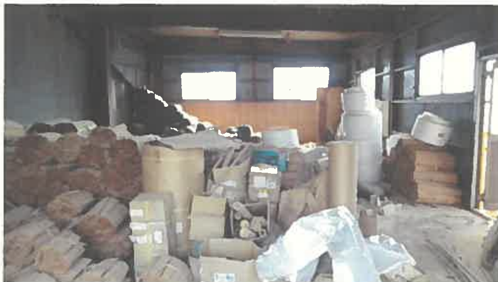
物件5 未登記附属建物内部の状況（2階）
