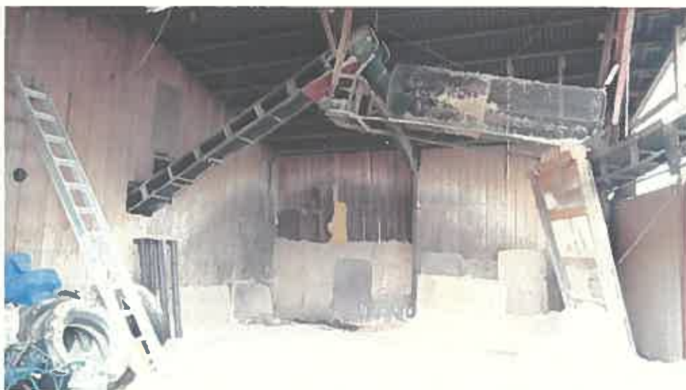
物件4 建物内部の状況
