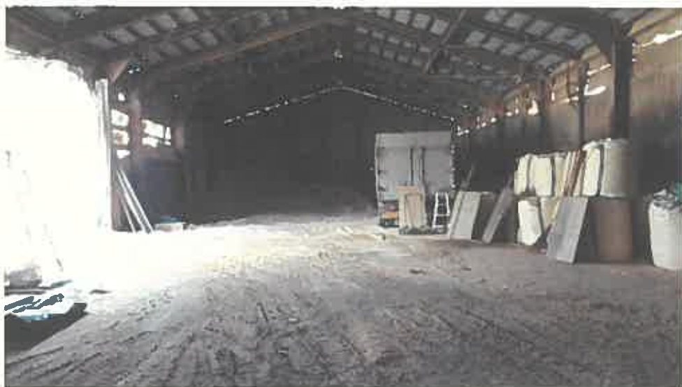
物件 5 主である建物内部の状況
