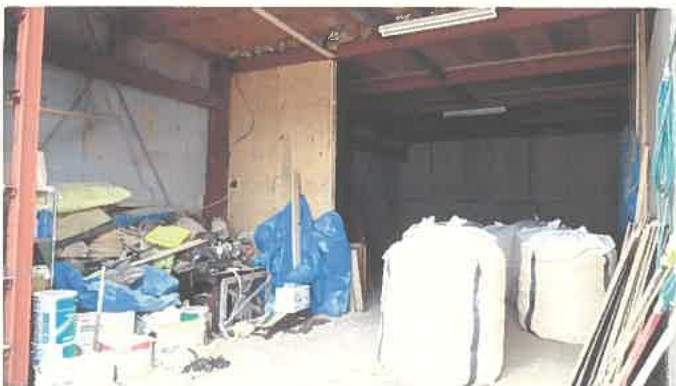
物件 5 未登記附属建物内部の状況（1 階）
