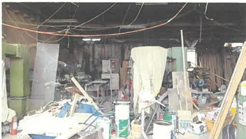
物件 7 建物内部の状況
