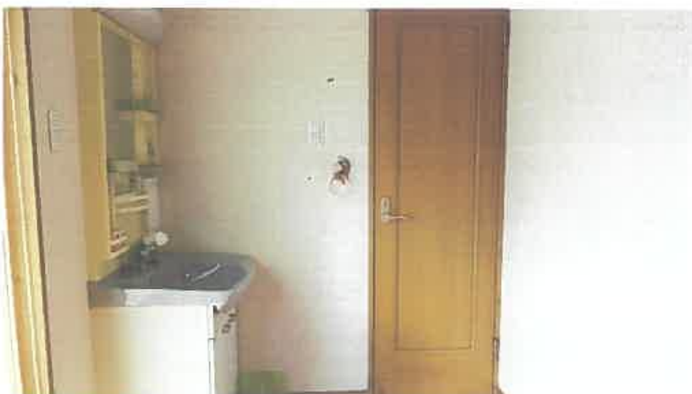
物件 2 建物内部の状況（3 階）
