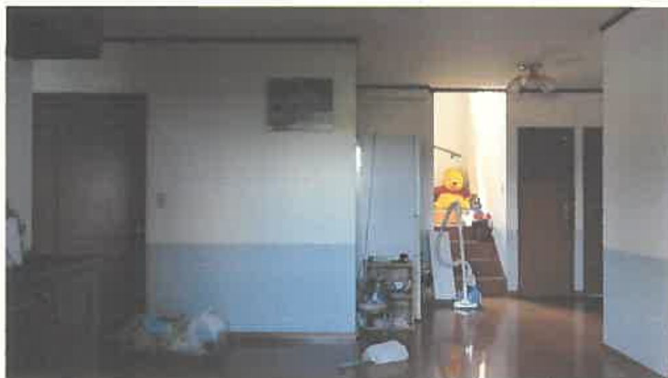
物件 3 建物内部の状況（1 階）
